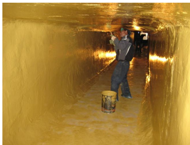
Нанесение химстойкого эпоксидного покрытия
