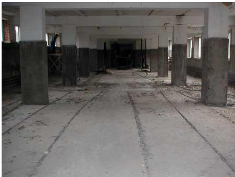
До проведения работ
