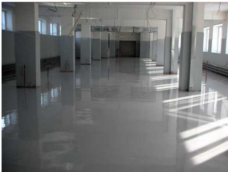
После проведения работ
